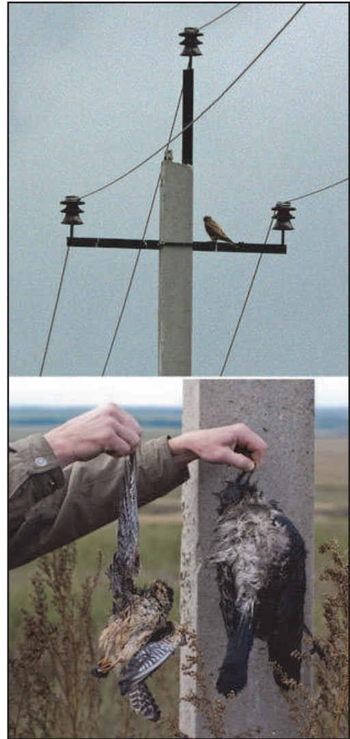
Пустельга, сидящая на птицепасной опоре ЛЭП (вверху) и кобчик ( Falco vespertinus ) и серая ворона ( Corvus cornix ), погибшие на опоре аналогичной конструкции (внизу). Фото Р. Бекмансурова и Д. Жукова.
