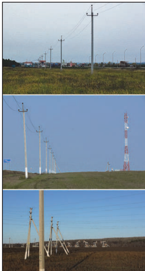
Птицепасные ЛЭП, подающие электроэнергию на автозаправочные станции (вверху), вышки сотовой связи (в центре), объекты нефтелобьичи (внизу). Фото Р. Бекмансурава.
