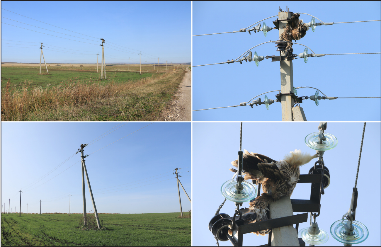
Рис. 3. Две параллельные птицепасные ЛЭП 6–10 кВ нефтяников в окрестностях с. Буралы Азнакаевского района (слева) и труп молодого орла-могильника (слётка) на оголовке анкерной опоры (справа). Фото Р. Бекмансурова.
